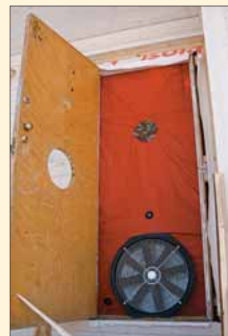
Fra utsiden av huset ses vifta til Byggforsks måleutstyr montert i hullet i plasten, som igjen er montert på rammeverket satt inn i døråpningen. Ned til venstre for vifta ses slangen som registrerer eventuell vind ute. I den midlertidige døra er hullet etter den lille vifta fra den forenklede målingen godt synlig.
